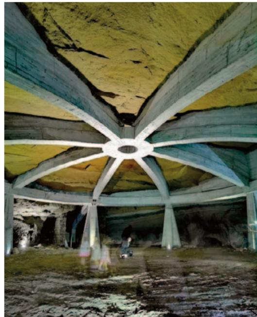
Grotta Giocarelli. Notare l'importante consolidamento in cemento armato con nervature a volta eseguito negli anni '90.
